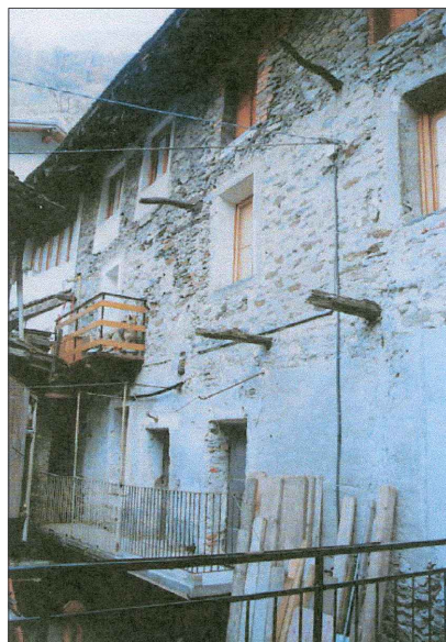
Vista interna edificio 82 (colore bianco avorio) prima del restauro 2009
