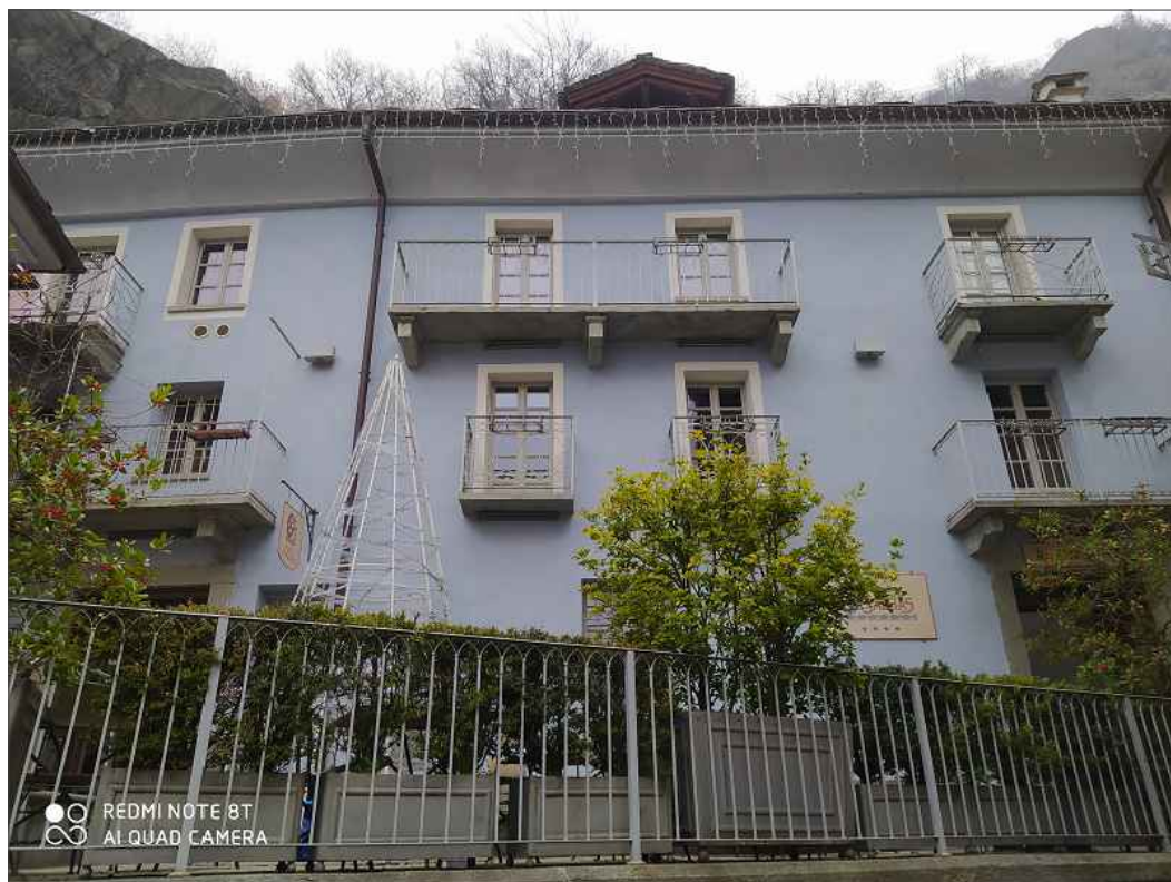
PROSPETTO FRONTE STRADA DOPO L'INTERVENTO DI RISTRUTTURAZIONE 2007-2009
