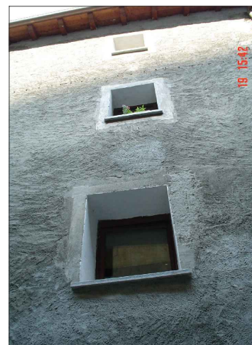
cornice a calce intorno alla finestra
