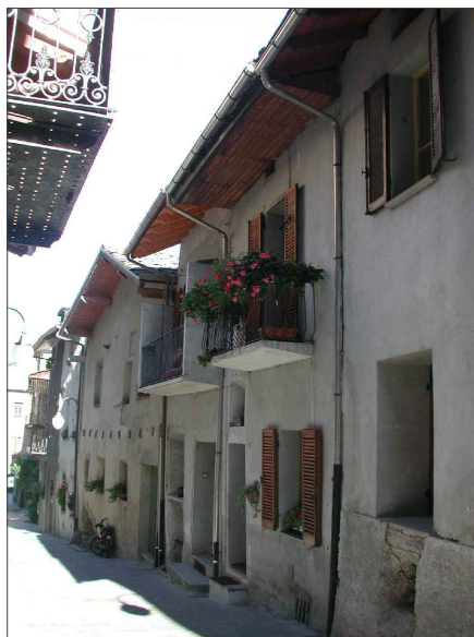
prospetto prima del restauro
