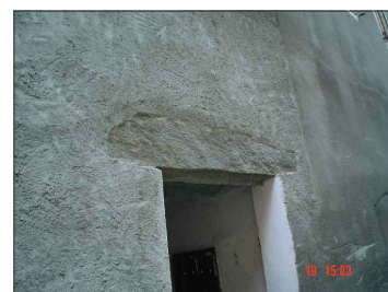
architrave in pietra sull'ingresso principale
