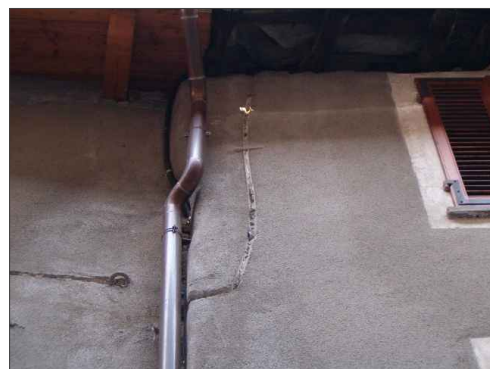
cornici intorno alle aperture
