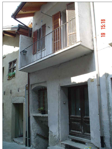
prima del restauro
