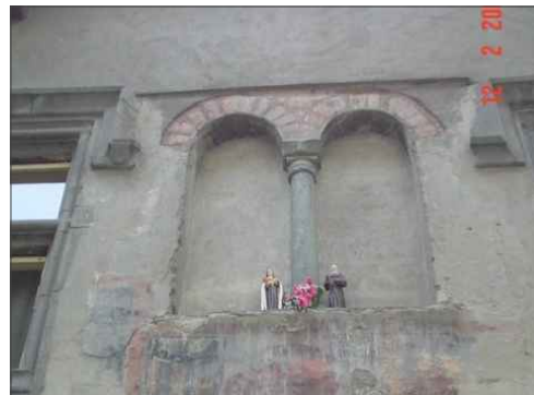
particolare bifora tamponata
