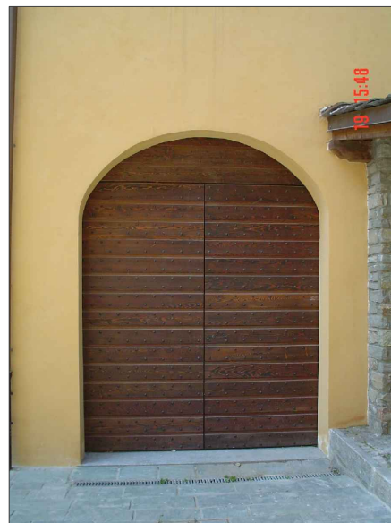
prospetto interno lato casa parrocchiale
