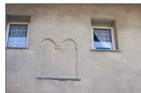
particolare bifora tamponata
