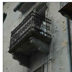
particolare del balcone
