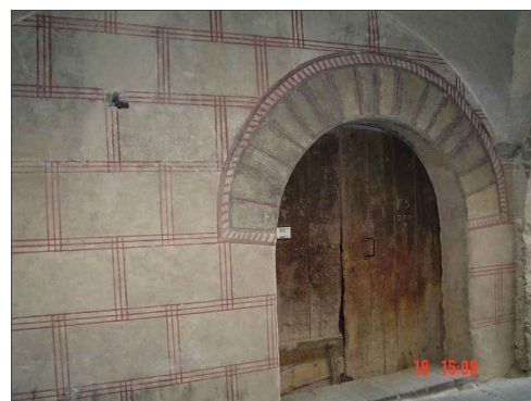
bugnato decorativo dipinto su intonaco
