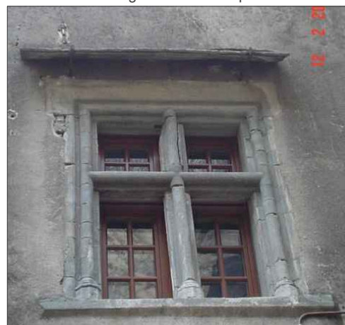
dettaglio quadrifora in pietra
