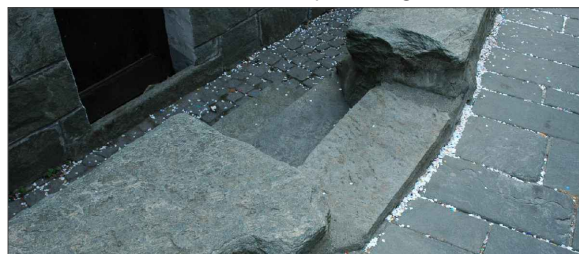
accesso in pietra all'edificio
