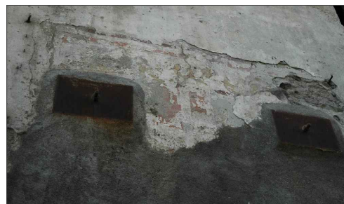
tra le due capochiave in ferro sono visibili tracce di una cornice con stemma affrescati prima
