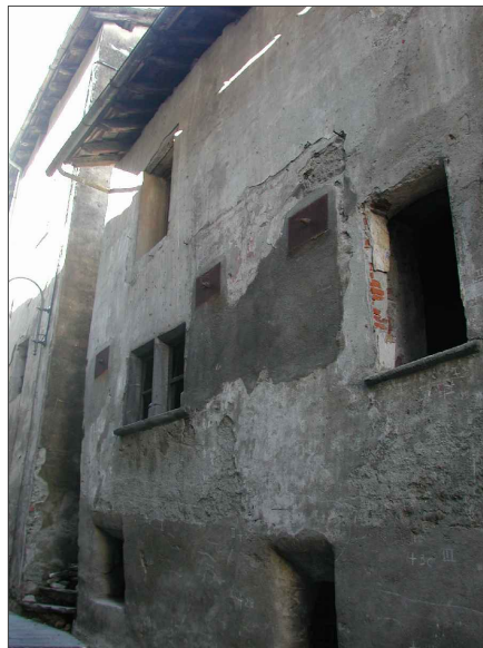
facciata prima del restauro
